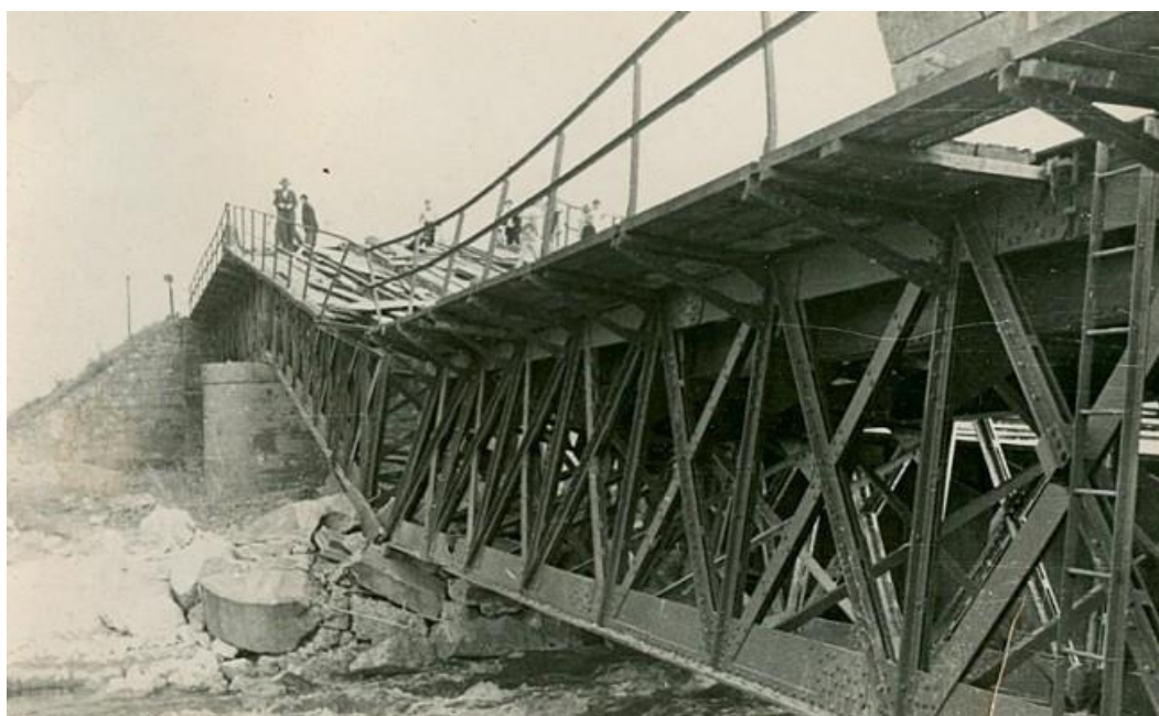
Závada – Němci zničený železniční most přes Olzu
